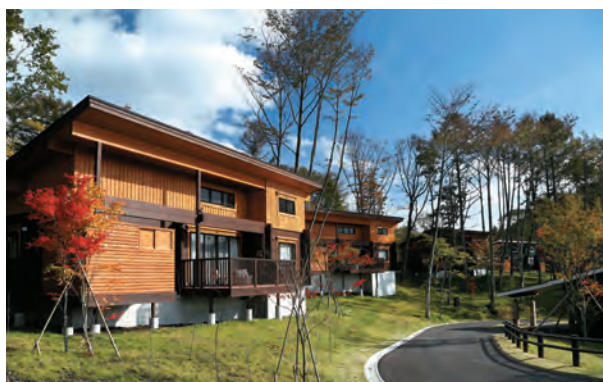
プリンス バケーションクラブ ヴィラ軽井沢浅間(外観)
