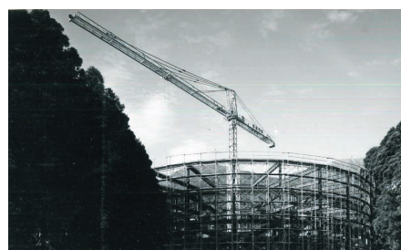
建設中の箱根プリンスホテル(現・ザ・プリンス 箱根芦ノ湖)
